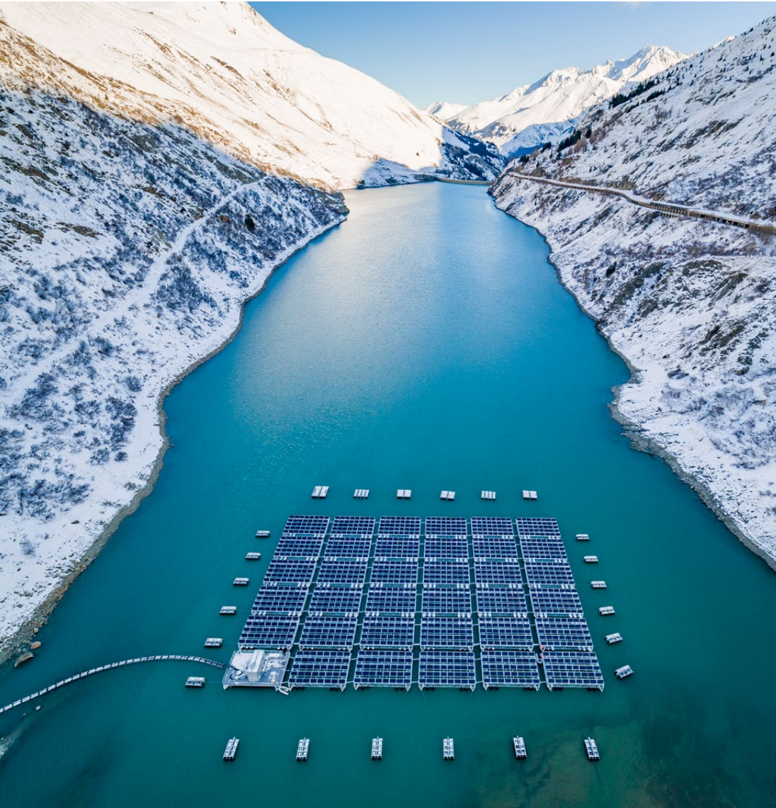
Quelle: Romand Energie. Schwimmende Solaranlage auf dem Lac des Toules, in der Walliser Gemeinde Bourg-Saint-Pierre.
