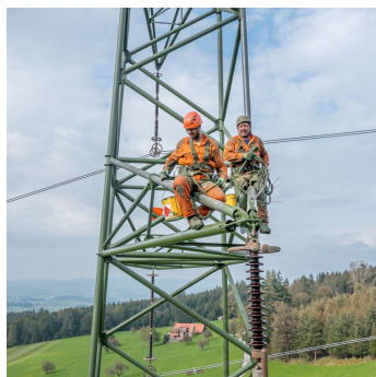
Infrastructure de réseau
