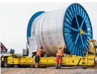
Infrastructure de réseau
