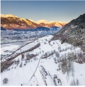
Infrastructure de réseau
