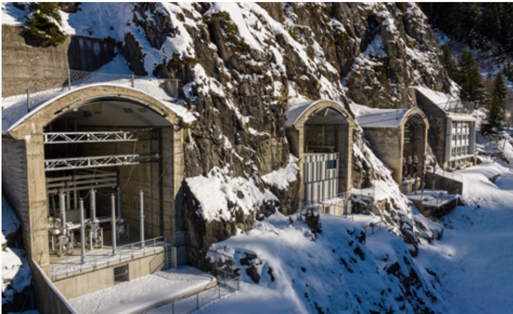
Swissgrid substation Fionnay GD in Valais
