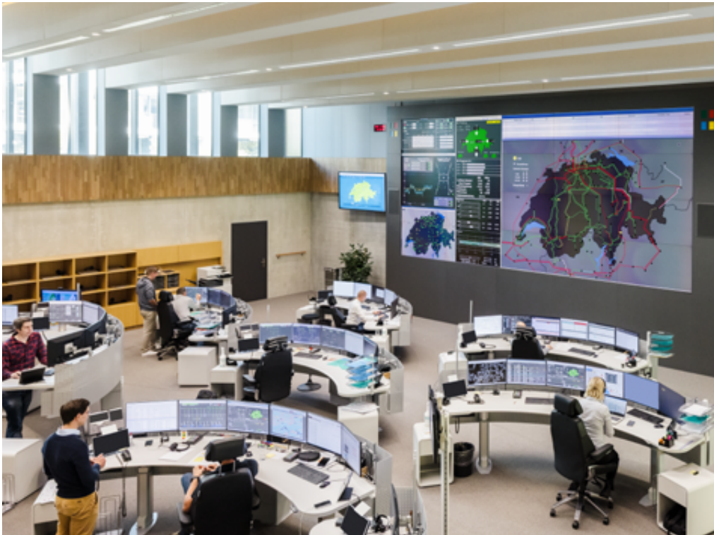
Die Mitarbeitenden im Swissgrid Control Center steuern das Netz 24/7
